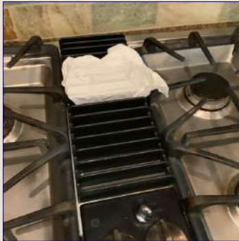
Exhaust fan operational.
